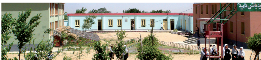
Erfolgsgeschichte: Aus einstigen Ruinen entstanden die heutigen Gebäude der Laghmanischulen, die von ca. 3000 Schülern besucht werden.
