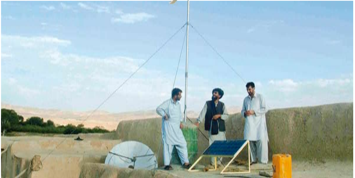
Ausgebildete Spezialisten installieren ein Windrad, um damit afghanische Haushalte mit Strom zu versorgen.
