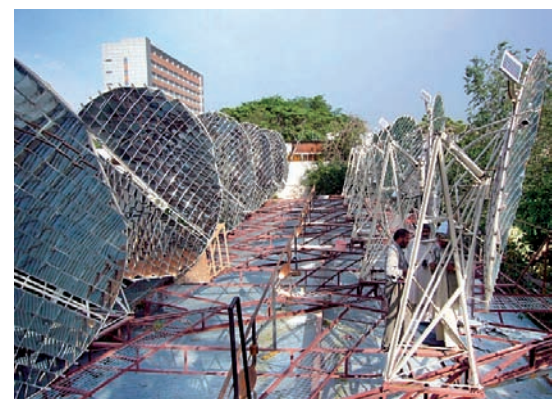
Die Scheffler-Reflektoren auf dem Dach versorgen die solare Dampfanlage in der Jamhuriatschule in Kabul mit Strom.
